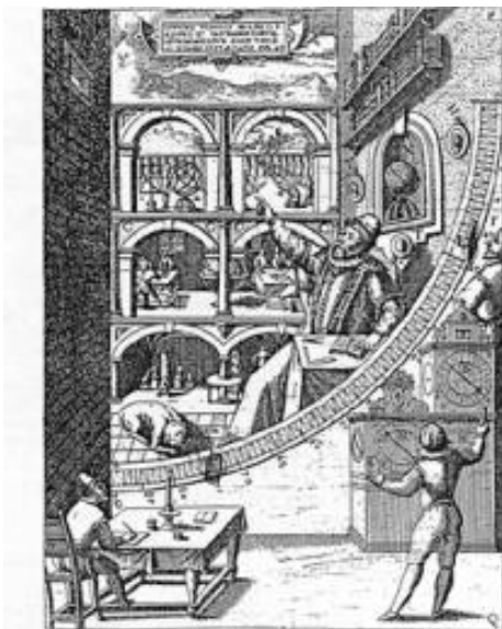
Abb. 8.1: Der Mauerquadrant von Tycho Brahe, der in der Mitte sitzt. Ein Assistent rechts am Rand beobachtet einen Stern durch die Öffnung in der oberen Hälfte der linken Mauer.
