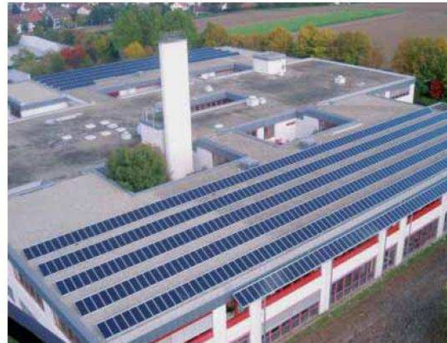
CIGS - Anlage auf einer Schule in Marbach a. N.
